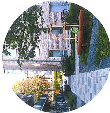
Mot gården mynnar stuprör i stora planterings- ytor och plattlagda gångar avvattnas mot vegetationsytor. (Sara Spjeller, Urban)
